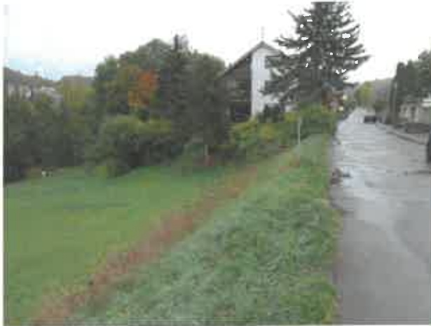
1 Böschung entlang des Craintaler Weges © Klärle GmbH, 25.1.2021
