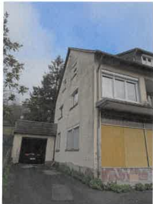
Am östlichen Giebel befinden sich noch Fensterläden (Lamellen), an den Fenstern der anderen Seiten, z.B. am westlichen Giebel, wurden Vorbau-Rollos aus Aluminium angebracht.
